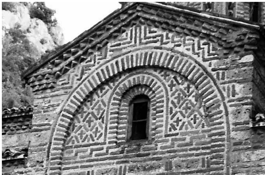
Сл. 13: Манастир Заум , Северна фасада цркве (фото. Б. Цветковић)
