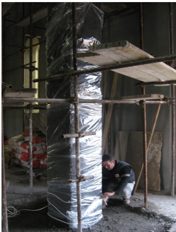
Слика 56. Постављање пластичних фолија
