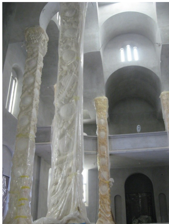
Слика 57. Пластичне фолије постављене после седмог дана од формирања облика
