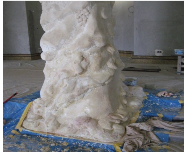
Слика 32. Свеж бетон нанесен на сазрели бетон
