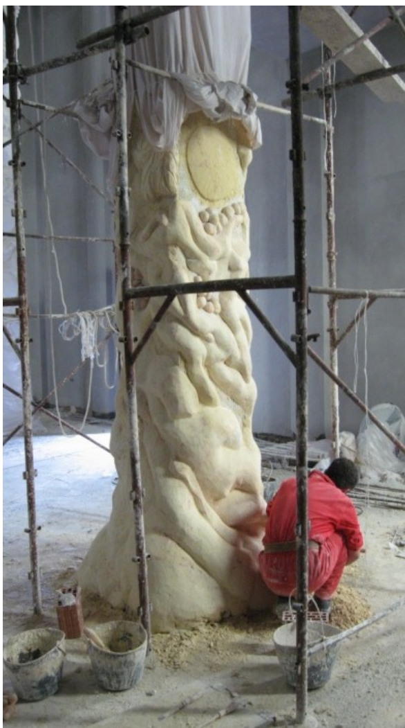
Слика 33. Моделовање свеже смесе
