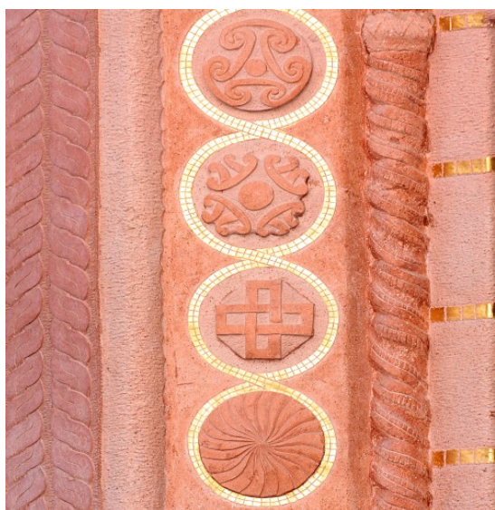
Слика 54. Позлата после полирања северни портал
