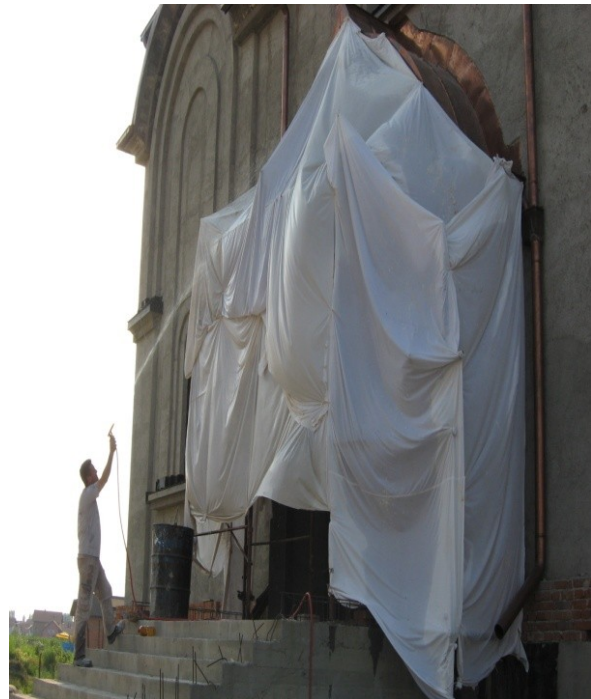
Слика 59. Влажење прскањем и стварање микроклиме при изузетно високој температури ваздуха
