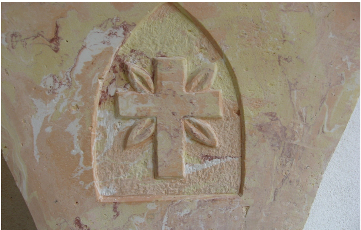
Слика 45. Детаљ капитела са контролисаним замесом површине за обраду. Манастир Каона, Србија
