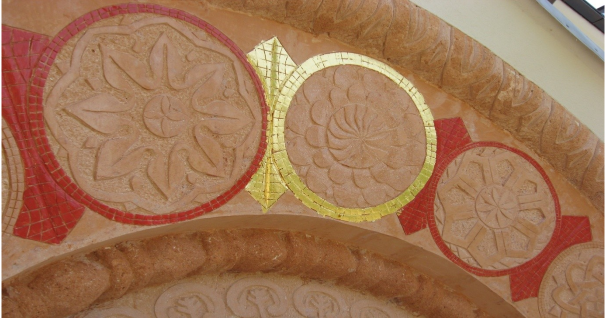
Слика 52. Детаљ, јужног портала цркве Свете Петке, Бијељина. Поступак позлате бетона
