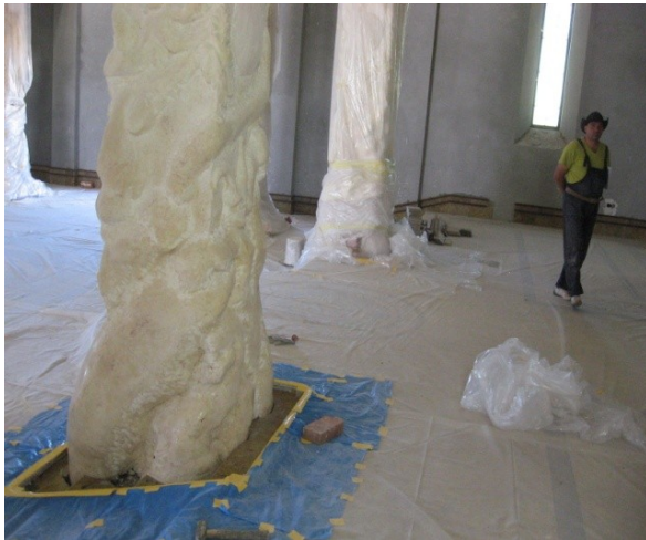
Слика 31. Сазрели, стари бетон
